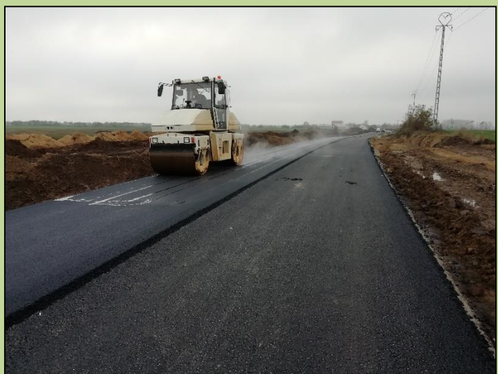
2. réteg aszfalt az ipari park újtjára
