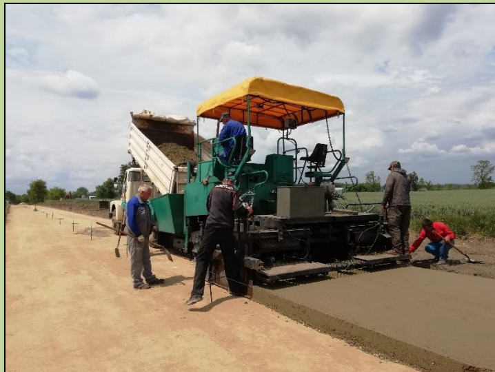
20 cm-es betonréteg az útalapra
