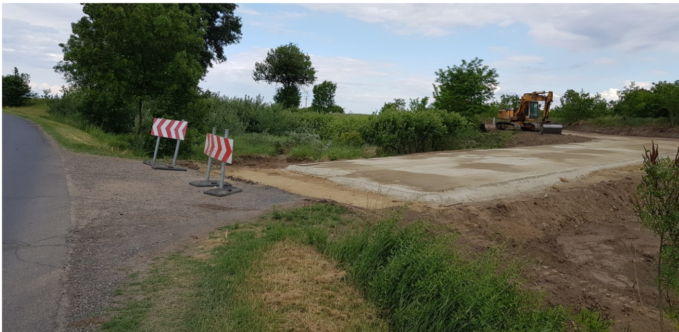
Építés alatt álló útcsatlakozás Forrás: Saját.
