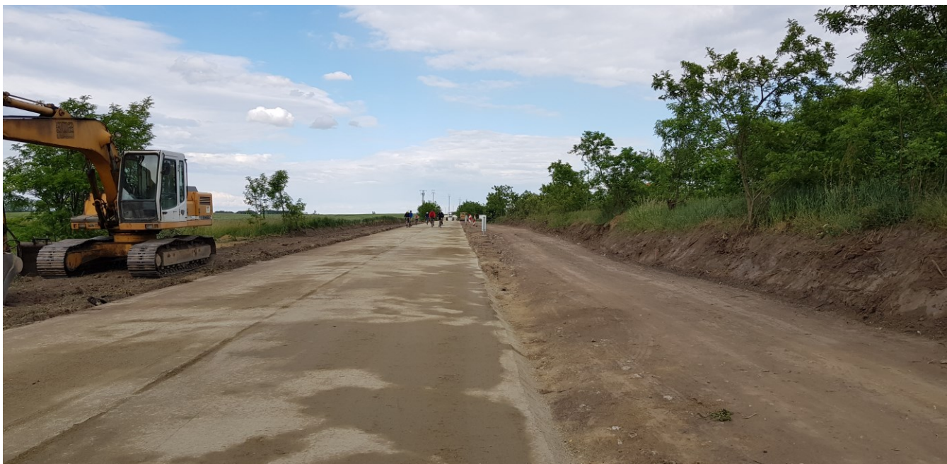
Építés alatt álló szennyvíztelepi út. Forrás: Saját.
