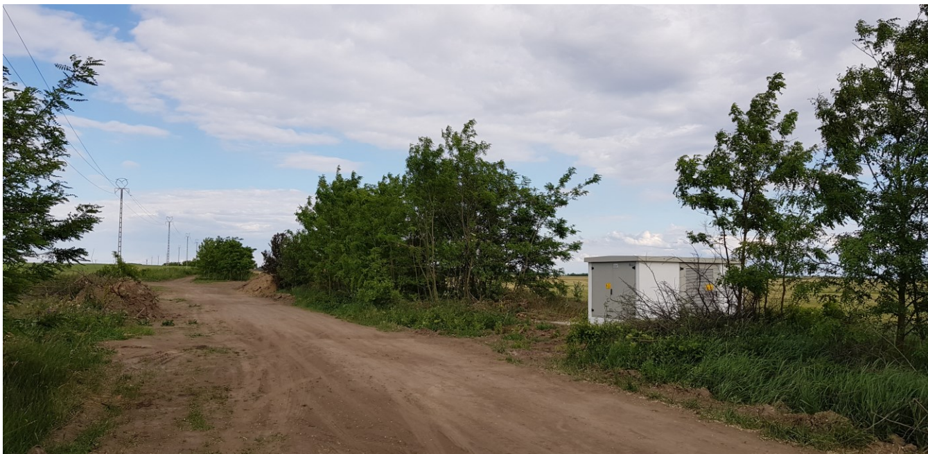
Megépült elektromos rendszer. Forrás: Saját.
